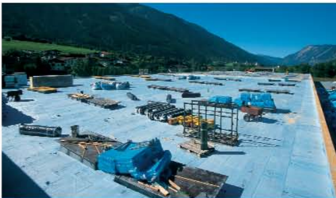
Schützende ROOFMATE Dämmschicht auf dem Umkehrdach des Auslieferungslagers Billa, Innsbruck
