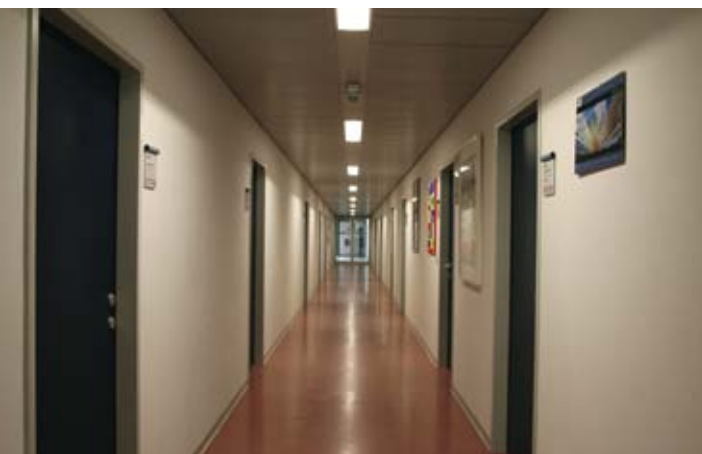
LED-Tubes wurden hier anstatt der üblichen Leuchtstoffröhren eingesetzt. © MA39 - VFA / Lichttechniklabor
