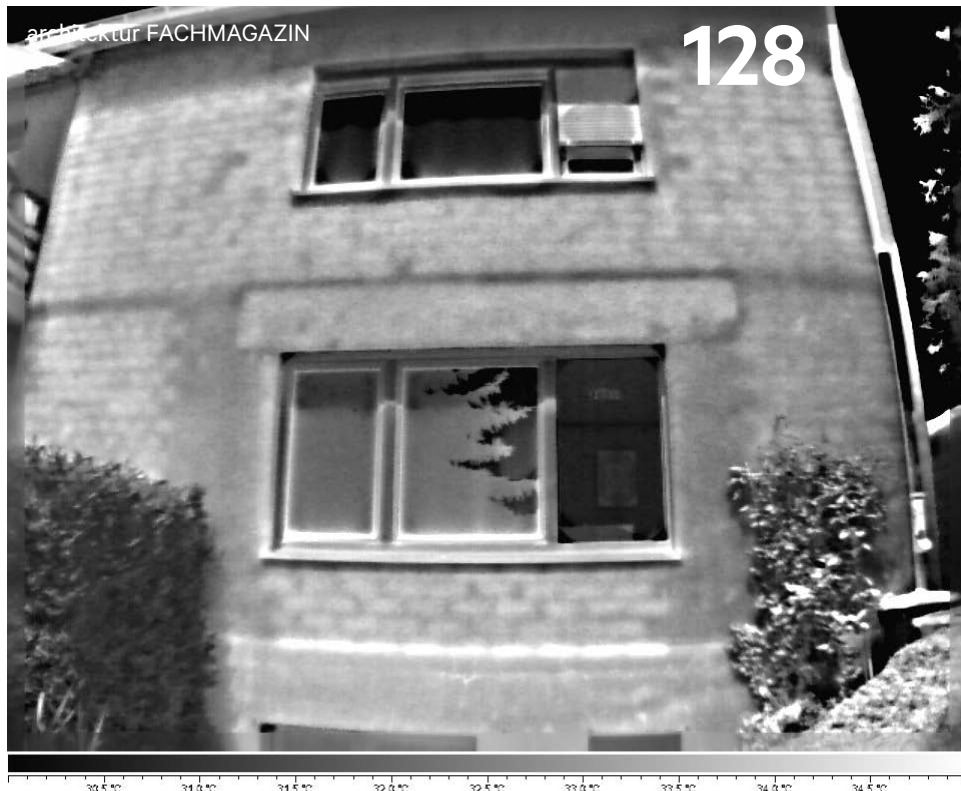
Beispiel Bauteilstruktur: Durch die Sonneneinstrahlung werden die inneren Strukturen des verputzten Altbaus sichtbar. © Dittl
