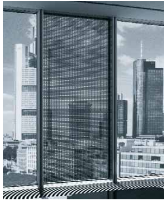
Solarthermische Energiegewinnung ermöglicht die Schüco E2 Fassade über großflächig in die Fassade integrierte Elemente mit neuen, transluzenten Flachkollektoren.
