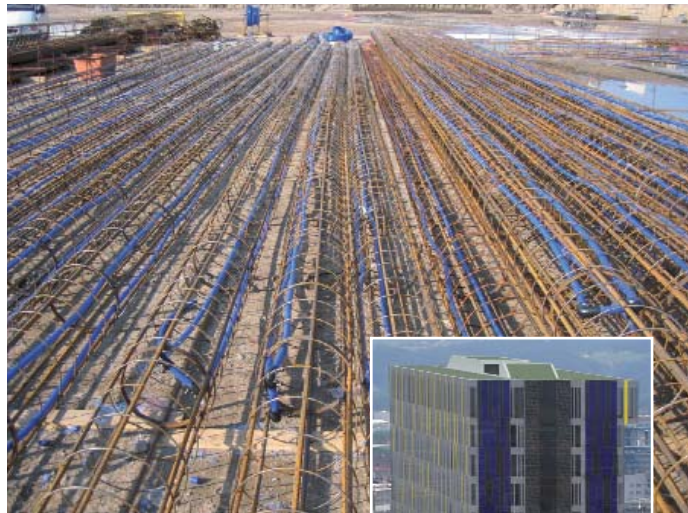
Betonfundamente liefern Energie für Heizung und Kühlung Bewehrungskörbe mit Absorberleitungen kurz vor Einbringen in die Bohrlöcher.
