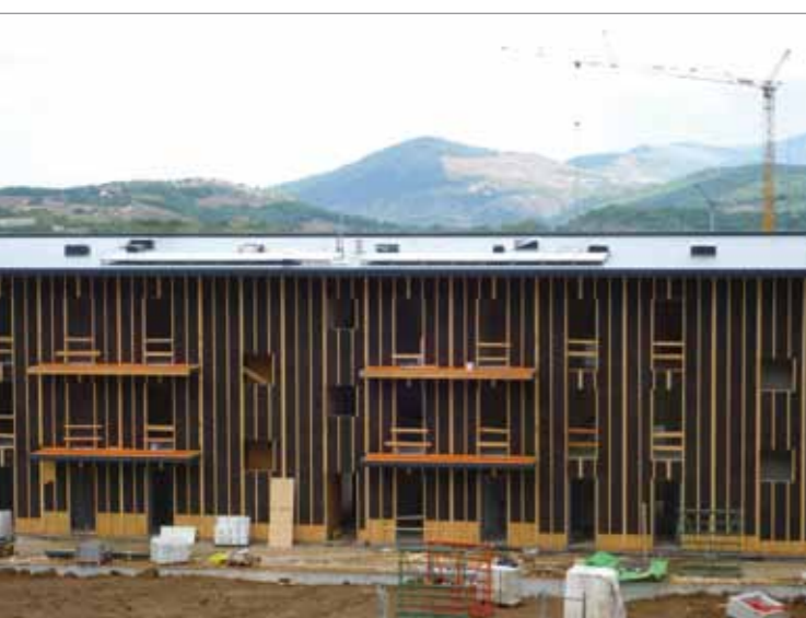
In drei Monaten zur schlüsselfertigen Wohnung mit der Holz-Massivbauweise in Brettsperholz.
