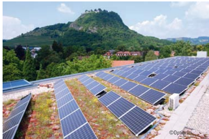
Das Dach zweimal genutzt: Photovoltaik und Gründach
