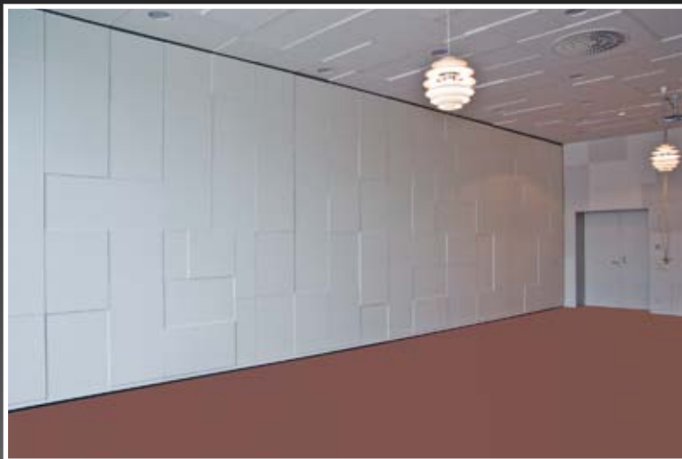
WKO Schwechat Palace 110iS, 47dB mit Aufdopplungen - Teilung in Wand und Decke übergehend
