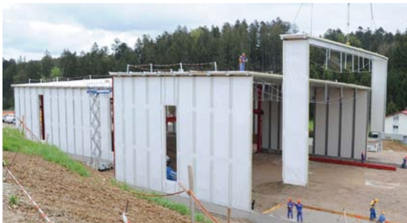
Fix und fertige Elemente mit einer Spannweite von 29,10 Meter werden zu einer Halle zusammengefügt.
