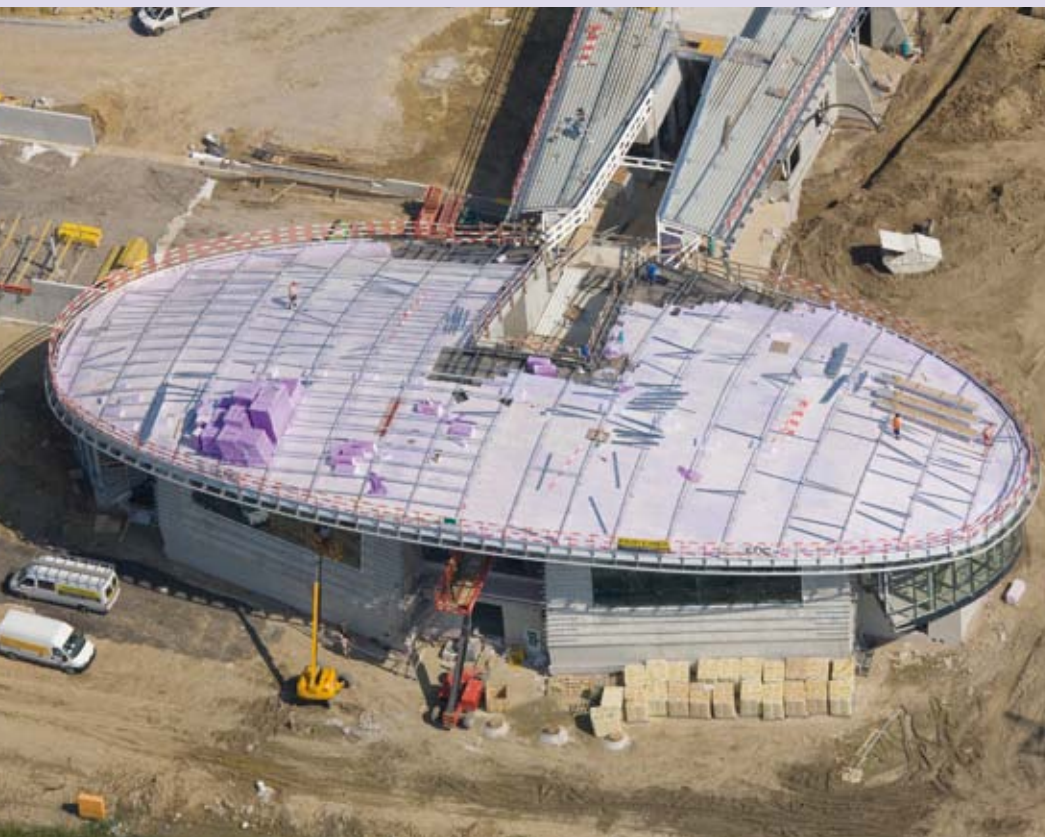
Dach- und Perimeterdämmung mit JACKODUR KF 300 Standard PGC Power Grid Control, Wien
