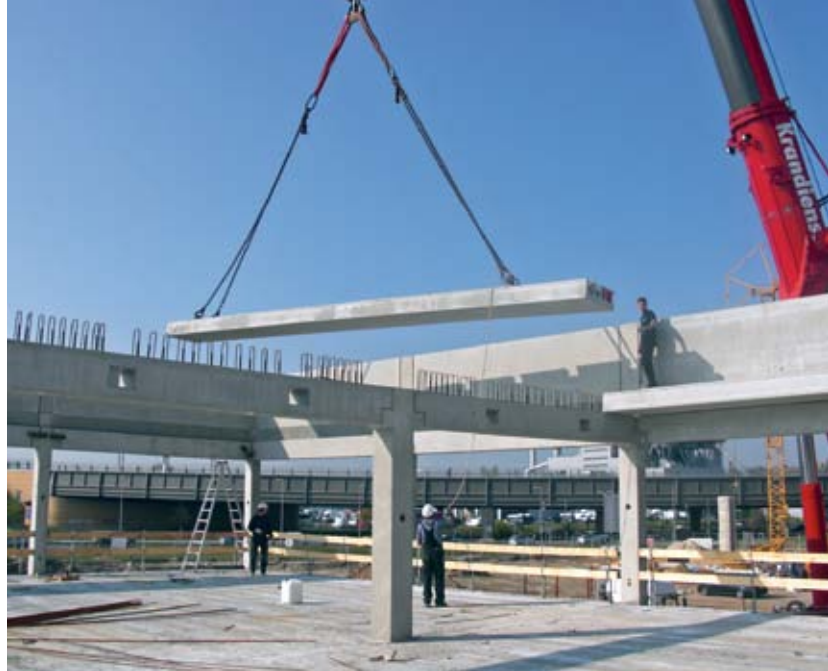
Die thermisch aktivierte Spannbeton-Fertigdecke wird vorgefertigt zum Einbau geliefert.
