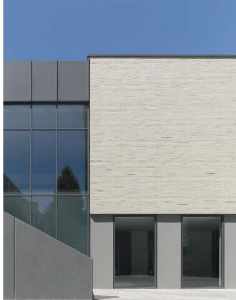
Fassadenausschnitt im Übergang zwischen dem verlinkerten Speisesaal und dem eingeschobenen, mit einer pulverbeschichteten Metallfassade bekleideten Baukörper der Essenausgabe.
