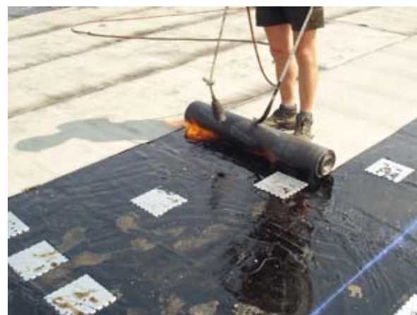
Aufflämmen der Sekundärabdichtungsbahn auf den Heißbitumen-Deckabstrich.
