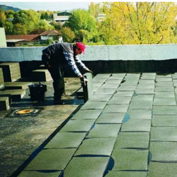
Einschwemmen der FOAMGLAS® Platten in Heißbitumen. Das Kompaktdach ist zugleich Dampfsperre und Dämmschicht.
